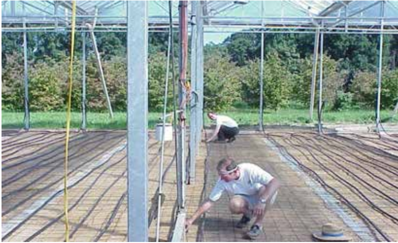
Слика 30 – Подно грејање стакленика
