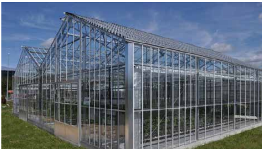
Слика 44 – Застакљен стакленик са фотонапонским панелима на крову
