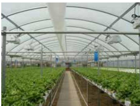
Слика 42 – Осветљење халогеним и живиним сијалицама
