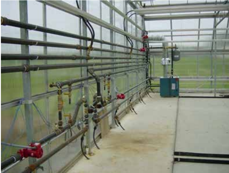
Слика 27 – Грејање бочних страна стакленика
