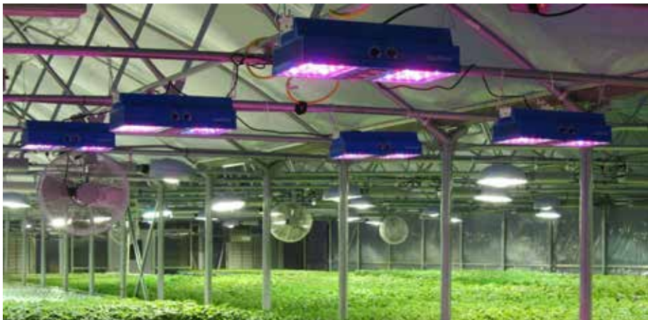
Слика 41 – Осветљење у стакленику
