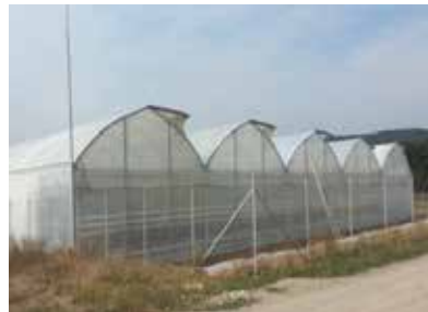
Слика 31 – Бочно и кровно проветравање
