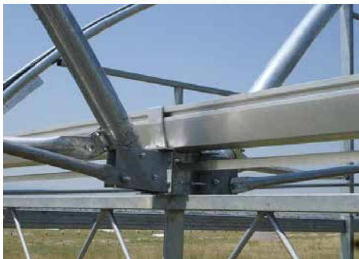
Слика 20 – Алуминијумски (поцинковани) олук између два стакленика
