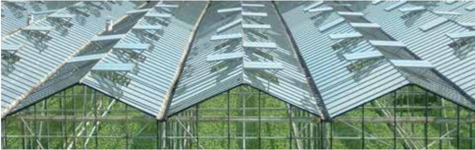
Слика 33 – Проветравање стакленика кроз појединачне кровне отворе
