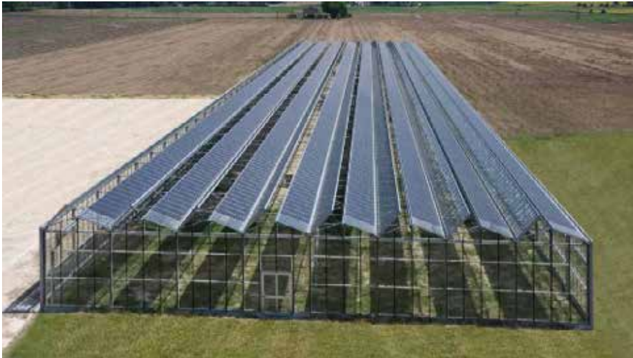
Слика 47 – Стакленик са соларним панелима
