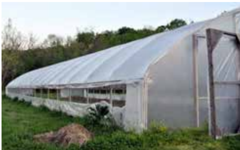
Слика 31 – Бочно и кровно проветравање
