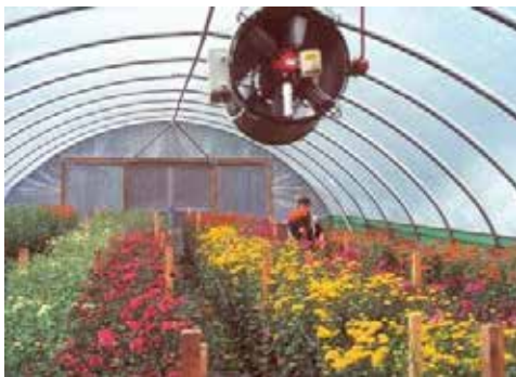
Слика 28 - Грејање калориферима
