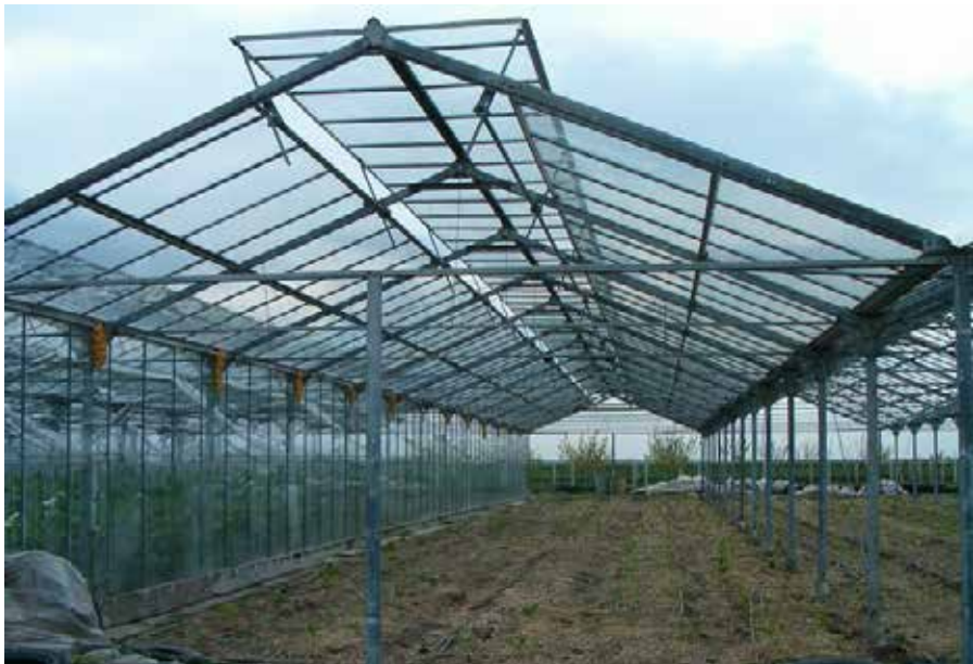
Слика 34 – Проветравање стакленика кроз кровне отворе
