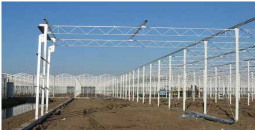
Слика 19 – Монтажа носећих рамова
