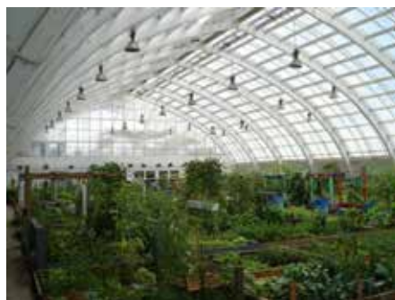
Слика 42 – Осветљење халогеним и живиним сијалицама
