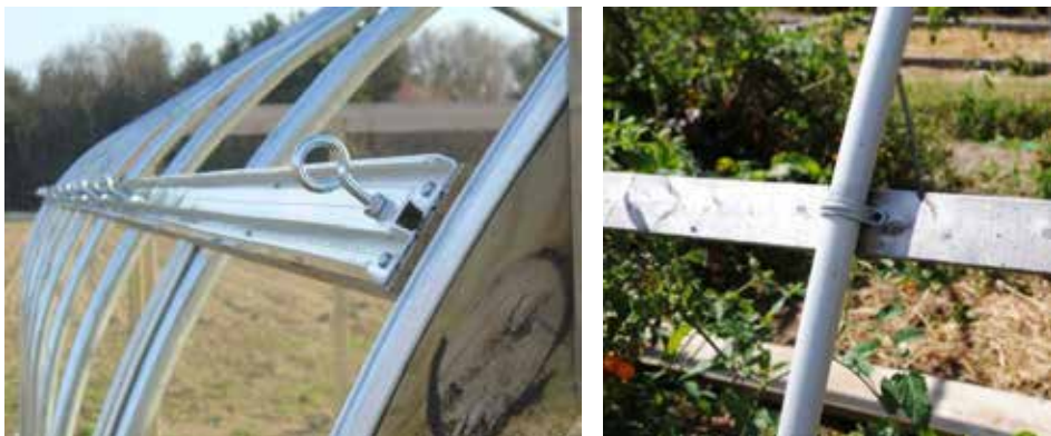
Слика б – Фиксирање рамова пре постављања пластика
